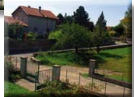
Dissimulation des réseaux secs en cours (rue des Croix)
