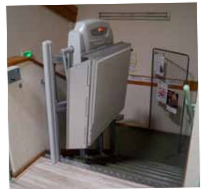
Nouvelle installation à la médiathèque
