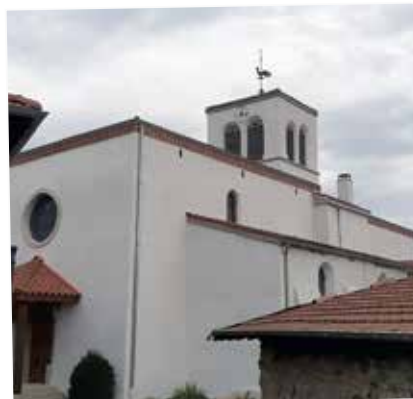
Ravalement des façades Eglise St Philibert
