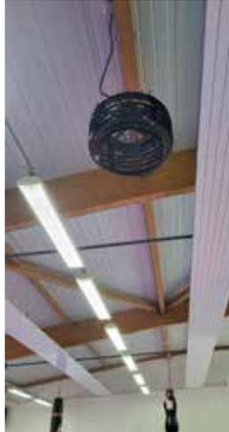
Pour un meilleur confort des utilisateurs, les destratificateurs qui homogénéisent la température de l'air ont été remplacés au gymnase et installés au Dojo
